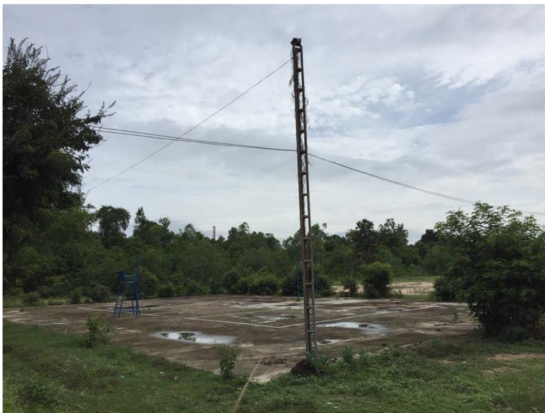
สนามฟุตบอลเทศบาลตำบลภูจองนายอยหมู่ที่๑๗ ที่ตั้งบ้านค้ำน้ำอ้อม หมู่ที่ ๑๗
